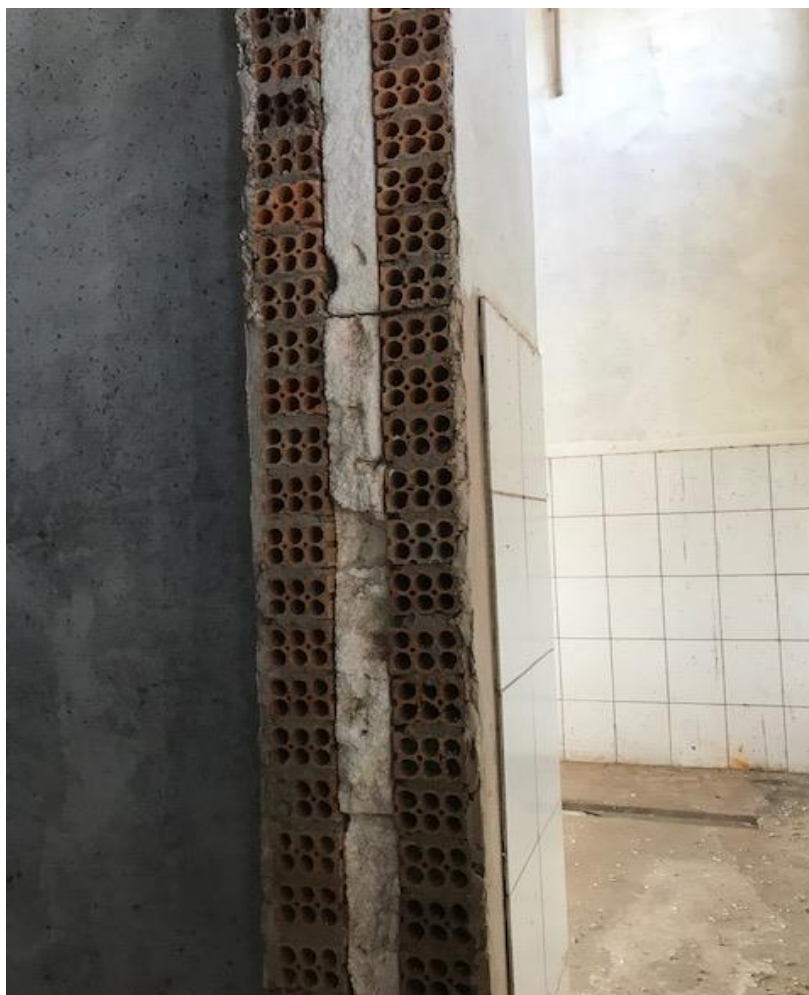
Imagem 04- Alvenaria dupla com isolamento em chapas de isopor
