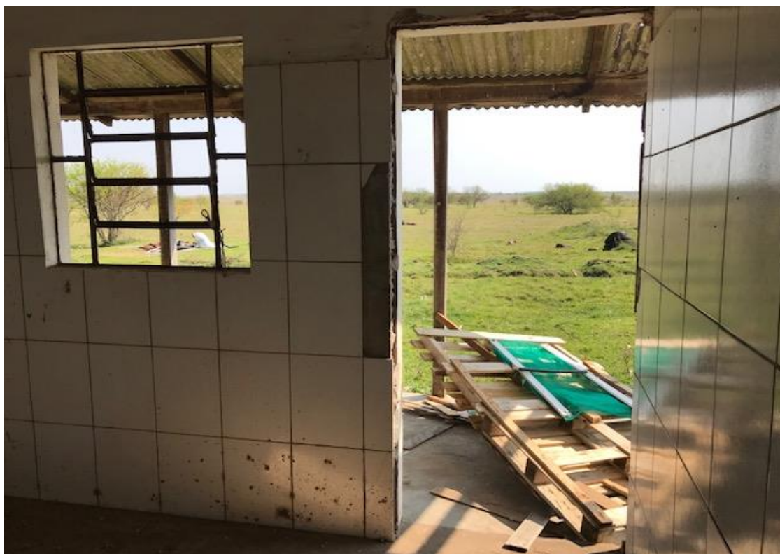
Figura 06 – Aberturas removidas e vidraças quebradas.
