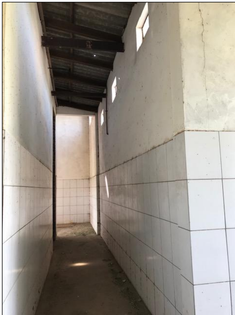
Imagem 03- Piso de cimento alisado, revestimento das alvenarias, Cerâmica, reboco.
