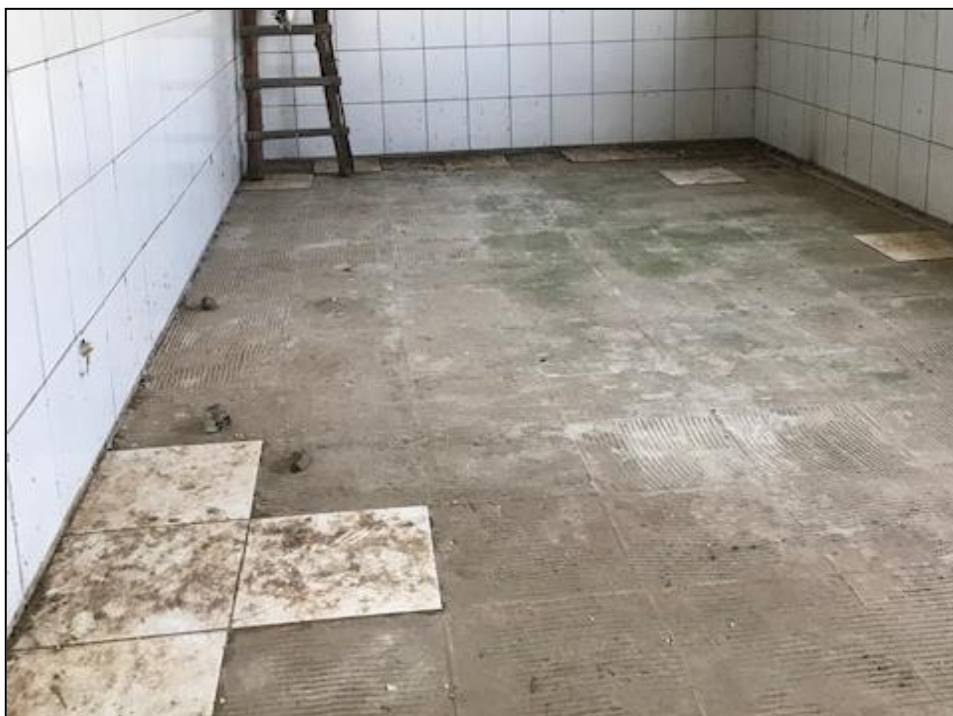
Imagem 02 – Estado do piso nos ambientes revestidos com cerâmica
