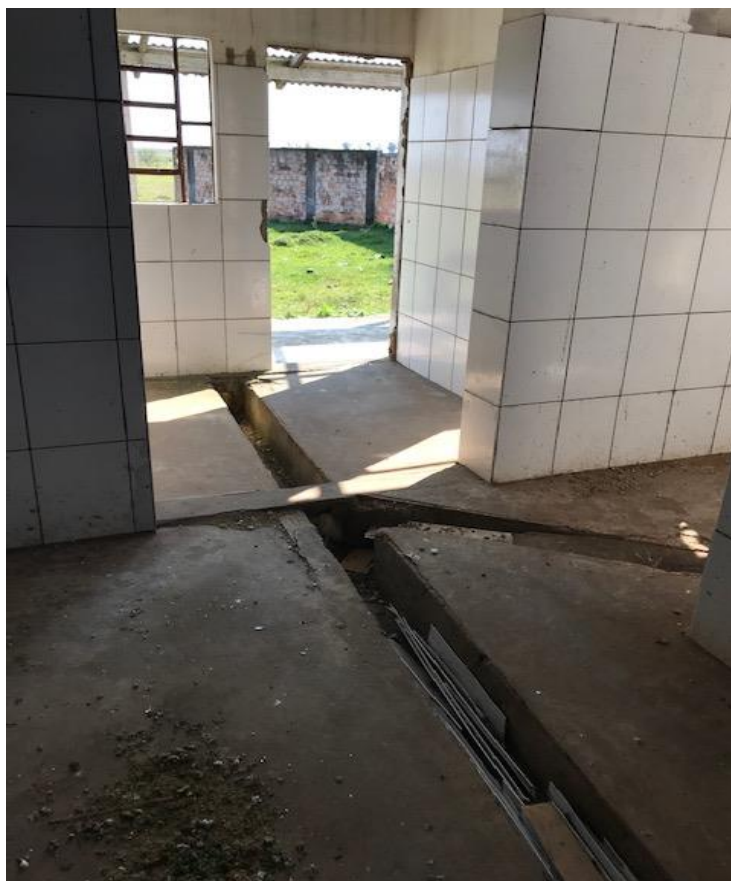
Imagem 04 – Canaletas de escoamento das águas do abatedouro
