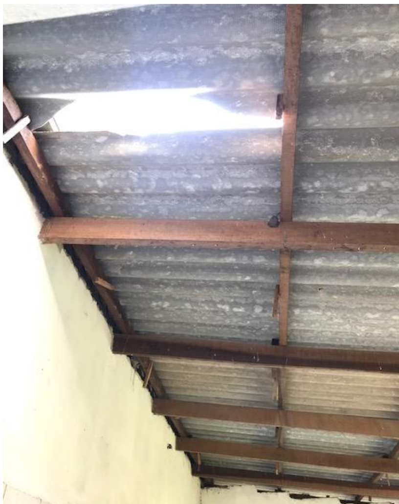
Imagem 05- Cobertura de fibrocimento danificada.
